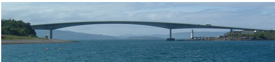
The Skye Road Bridge; Jörn Albring; http://cs.wikipedia.org/wiki/Soubor:Skye_Road_Bridge.JPG
